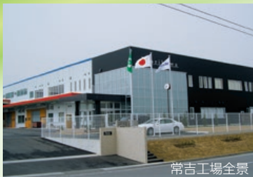
常吉工場全景
